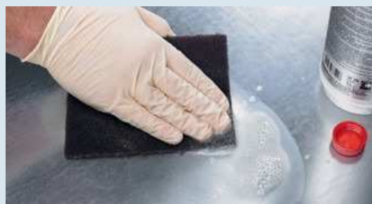
Preparare la superficie di zinco con un tampone per levigatura e SÜDWEST pulitore per zinco e plastica.
